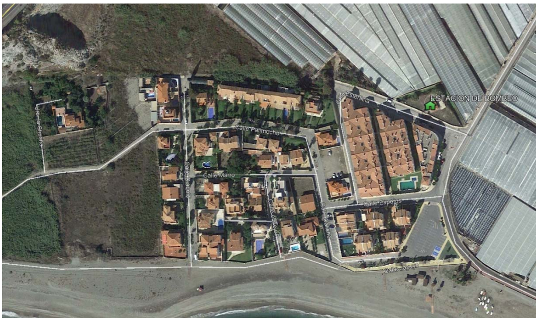
Ubicación de la Estación de Bombeo
